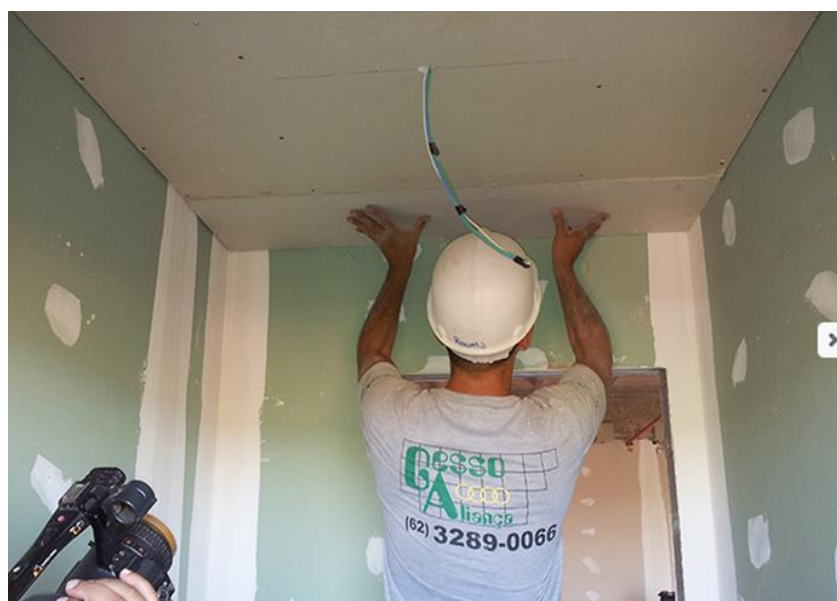
Figura 3 – Imagem da Instalação de Gesso
