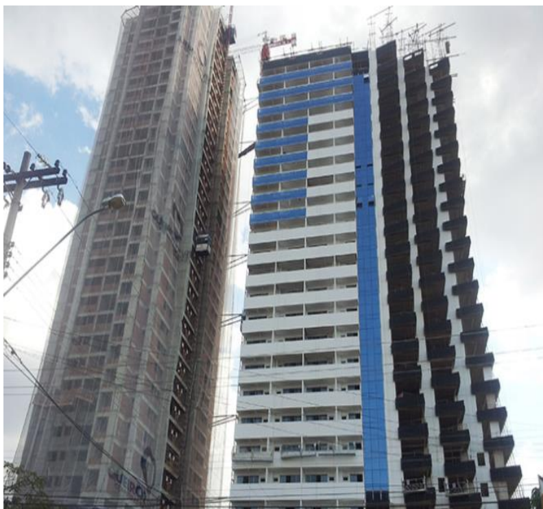
Figura 5 – Imagem da Instalação da Pele de Vidro na Fachada
