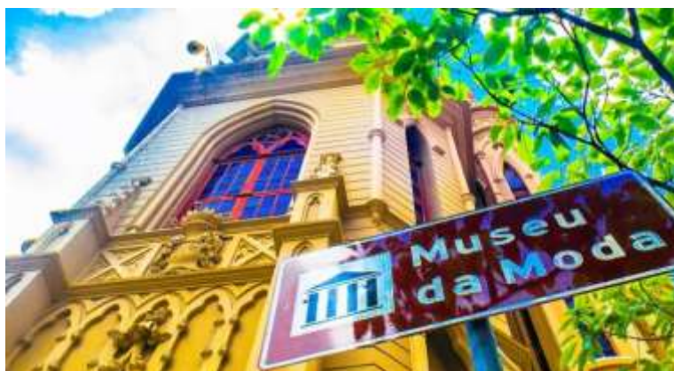
Figura 15 – Museu da Moda no prédio da Rua Bahia com Augusto de Lima
