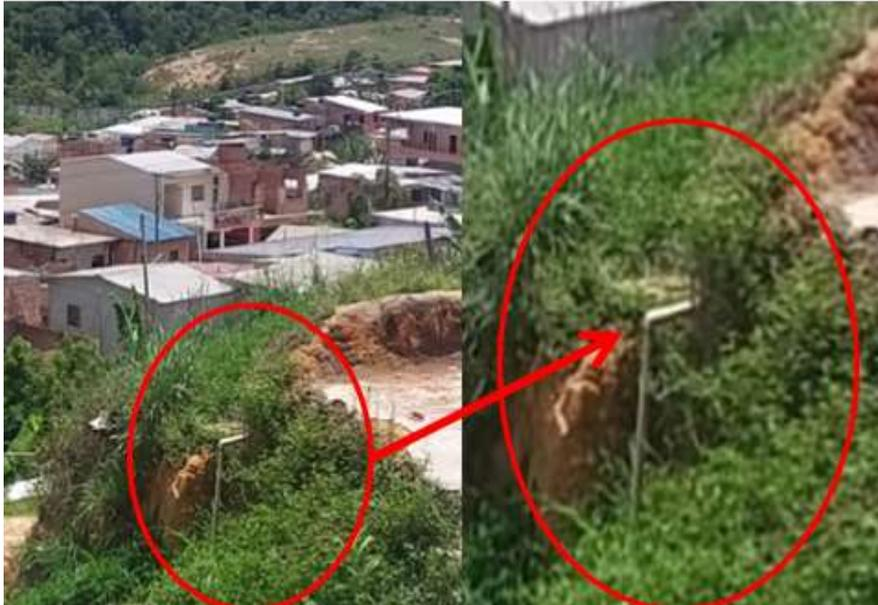
Figura 11. Lançamento de esgoto sem tratamento. Fonte: Dados da pesquisa.
